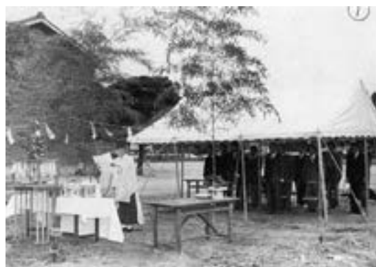
昭和35年 体育館建築工事地鎮祭
