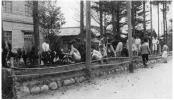
昭和16年 生垣更新作業
