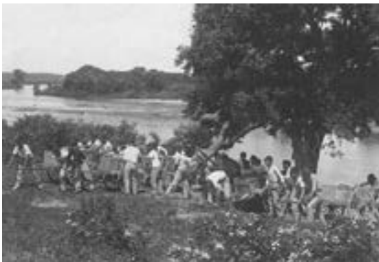
昭和3年 プール建設のための砂利運搬作業
